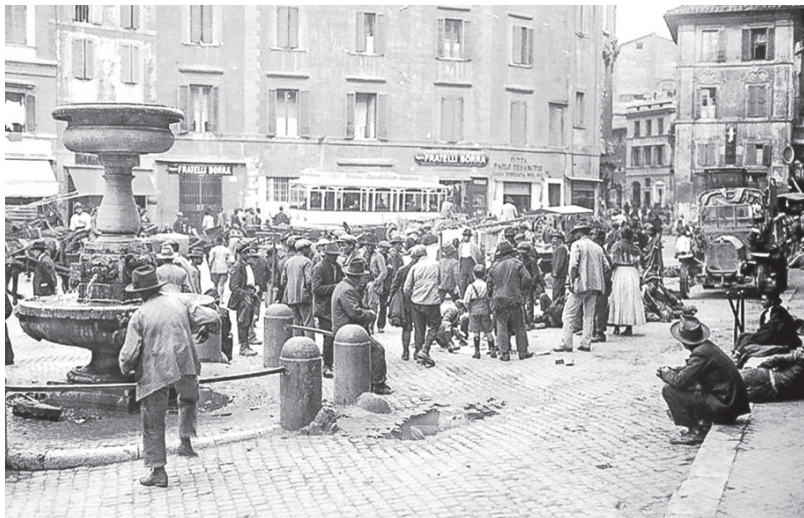
3. Piazza Montanara demolita per la costruzione di via del Mare.
