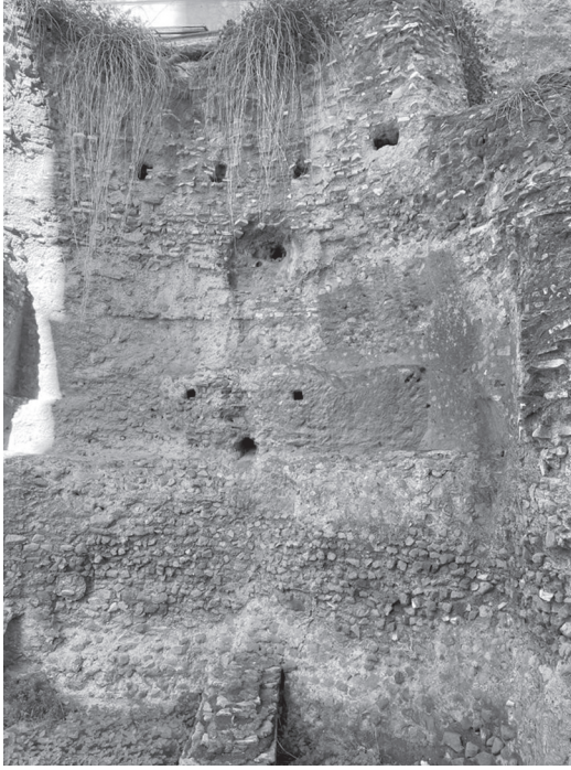
4. Ruederi del ninfeo tempio di Iside Metellino, in via Villari, colle Oppio.
